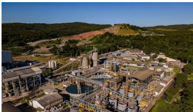
Instalações de Serra Grande
