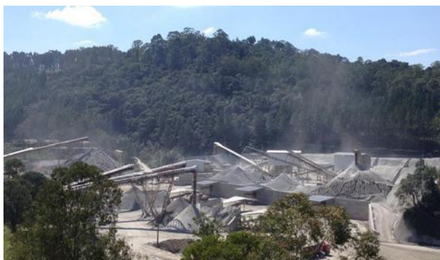
Paupedra -Pátio de britas da Paupedra, em Guarulhos (SP)
