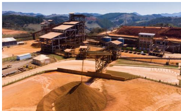
Usina de beneficiamento na Unidade de Miraflores (MG)
