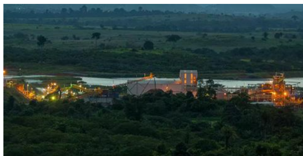
Instalação de beneficiamento da mina de Antas Norte
