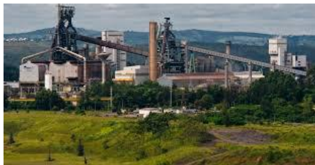
Gerdau Açominas - Complexo de Ouro Branco
