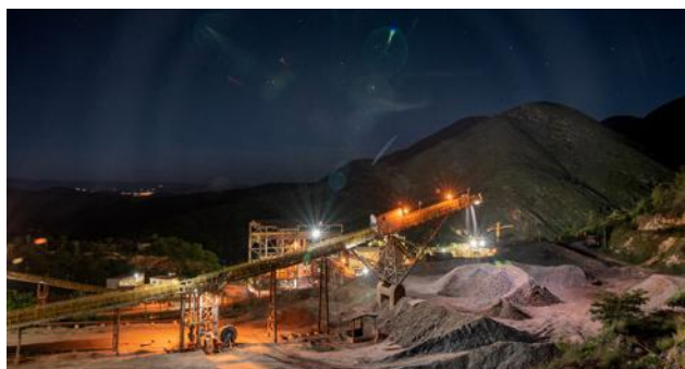
Vista noturna da esteira de transporte de minérios
