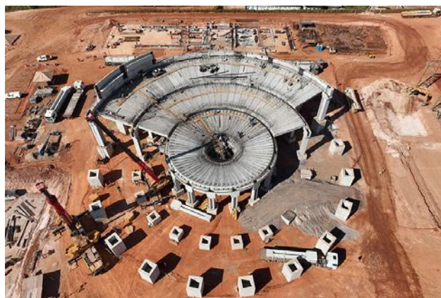
Construção da nova planta de filtragem de rejeitos
