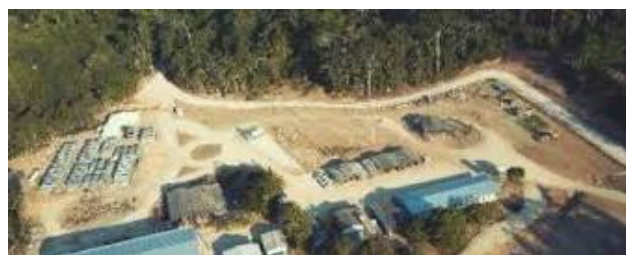
Chapleau - Instalações do Complexo Coringa
