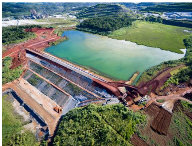
Instalações da Mosaic em Cajati (SP)
