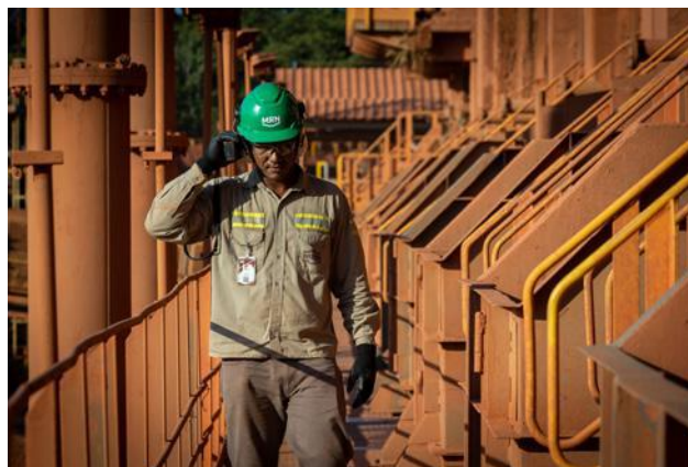
Usina de processamento de bauxita da MRN
