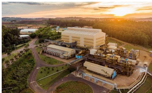
Nova planta da CBMM em Araxá (MG)
