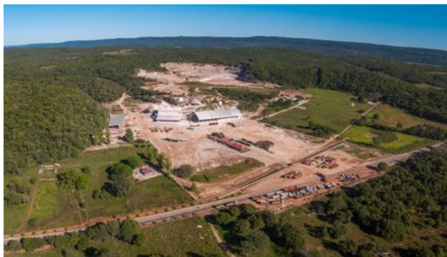
Emal - Instalações em Nobres (MT)
