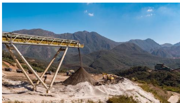
Pilha de minério
