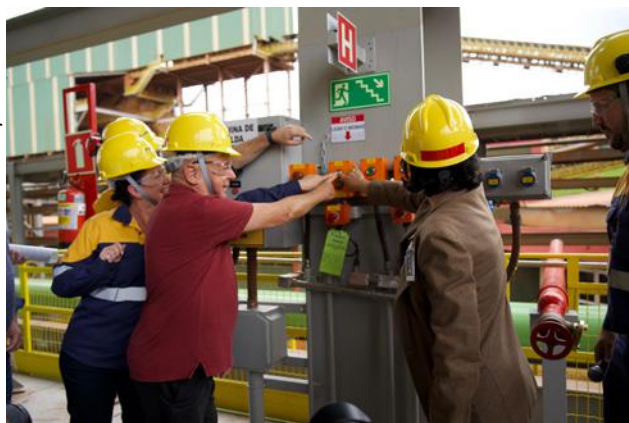
Acionamento da segunda planta de processamento de minério
