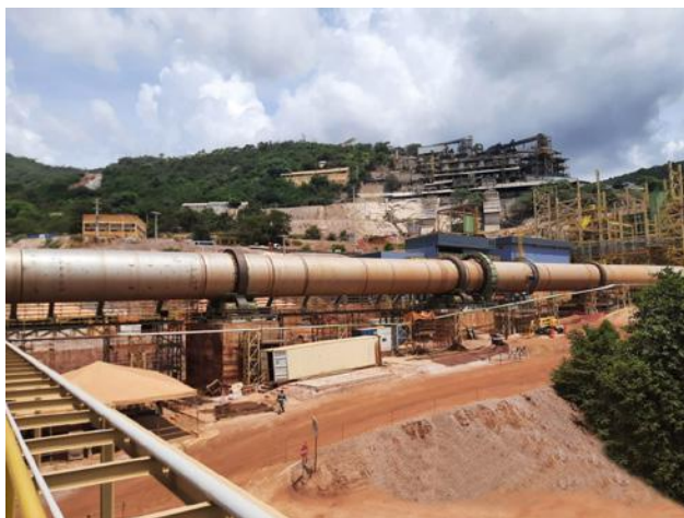
RHI Magnesita está investindo na construção de um novo forno rotativo
