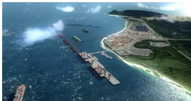
Obras do Terminal Porto Sul, da Bamin
