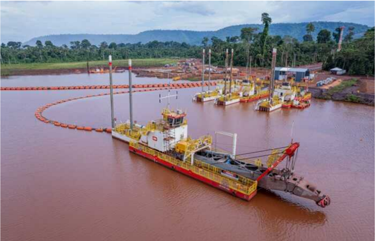
Dragas elétricas do Projeto Gelado
