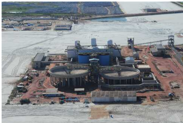
Obras na área do Porto
