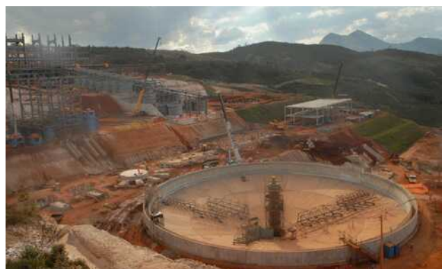
Obras em Alvorada de Minas
