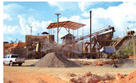
Circuito de britagem da Serabi
