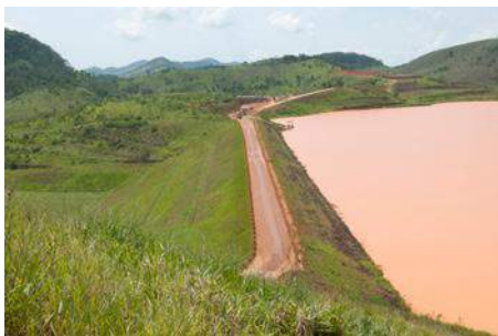
CBA - Barragem de Mirai
