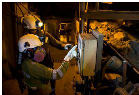
Painel de controle da mina subterrânea
