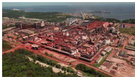
Projeto Hydro Paragominas
