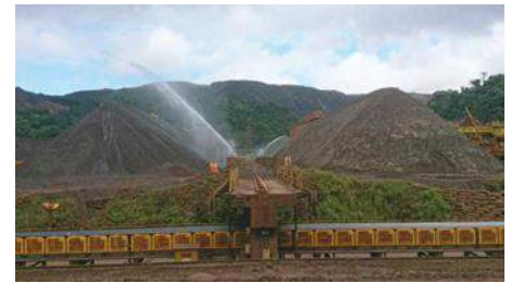
Aspersão de pilhas de minério realizada pela CSN Mineração
