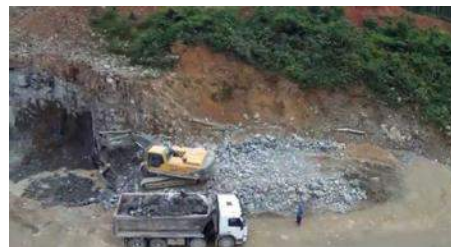
Carregamento de pedras na Britagem Vogelsanger
